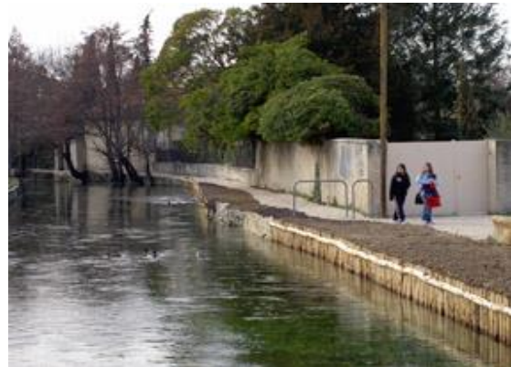
Figure 26- Aménagement associant réhabilitation des berges et création d'un chemin piétonnier (SMBS)
